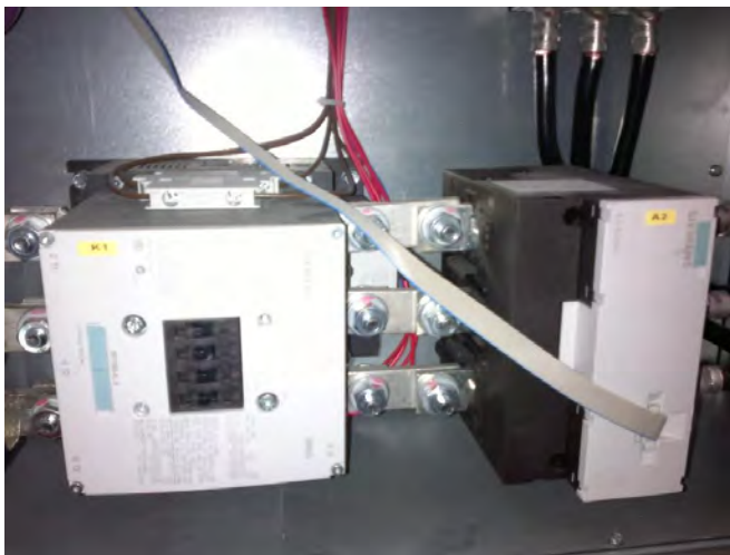
Kuva 32. Ohjausvirtapiirien väärä kaapelointireitti aiheuttaa pää- ja ohjausvirtapiirien välisen oikosulun riskin (© Juha Anttonen, Botnia Mill Service Oy).
