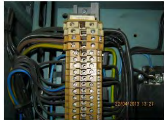
Kuva 42. Löystyneen riviliitinkytkennän vaikutus johtimen ja liittimen lämpötilan nousuun (© Hannu Halminen, Bolden Harjavalta Oy).
