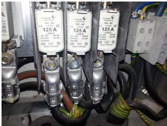
Kuva 28. Pulttiliitoksen vaillinainen viimeistely, pultti on liian lyhyt (© Pertti Kukkonen, Oy Elspecta Ab).
