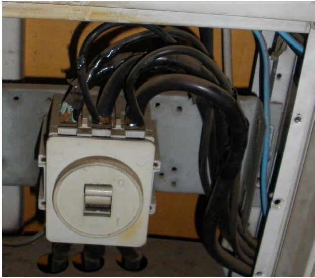
Kuva 21. Huonon liitoksen aiheuttama oksidoituminen ja eristemateriaalin sulaminen johtimessa (© Pertti Kukkonen, Oy Elspecta Ab).
